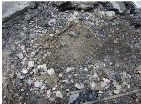
写真-3 舗装撤去後の状況
