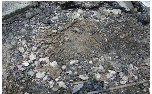
写真-3 舗装撤去後の状況
