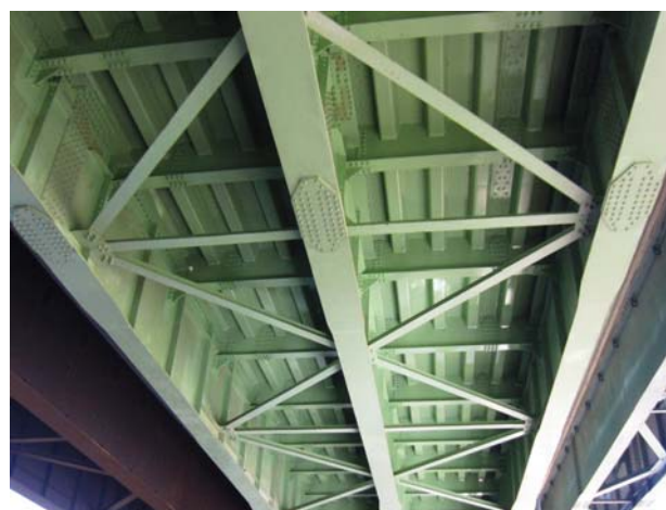
写真-6 完成後の鋼床版下面
